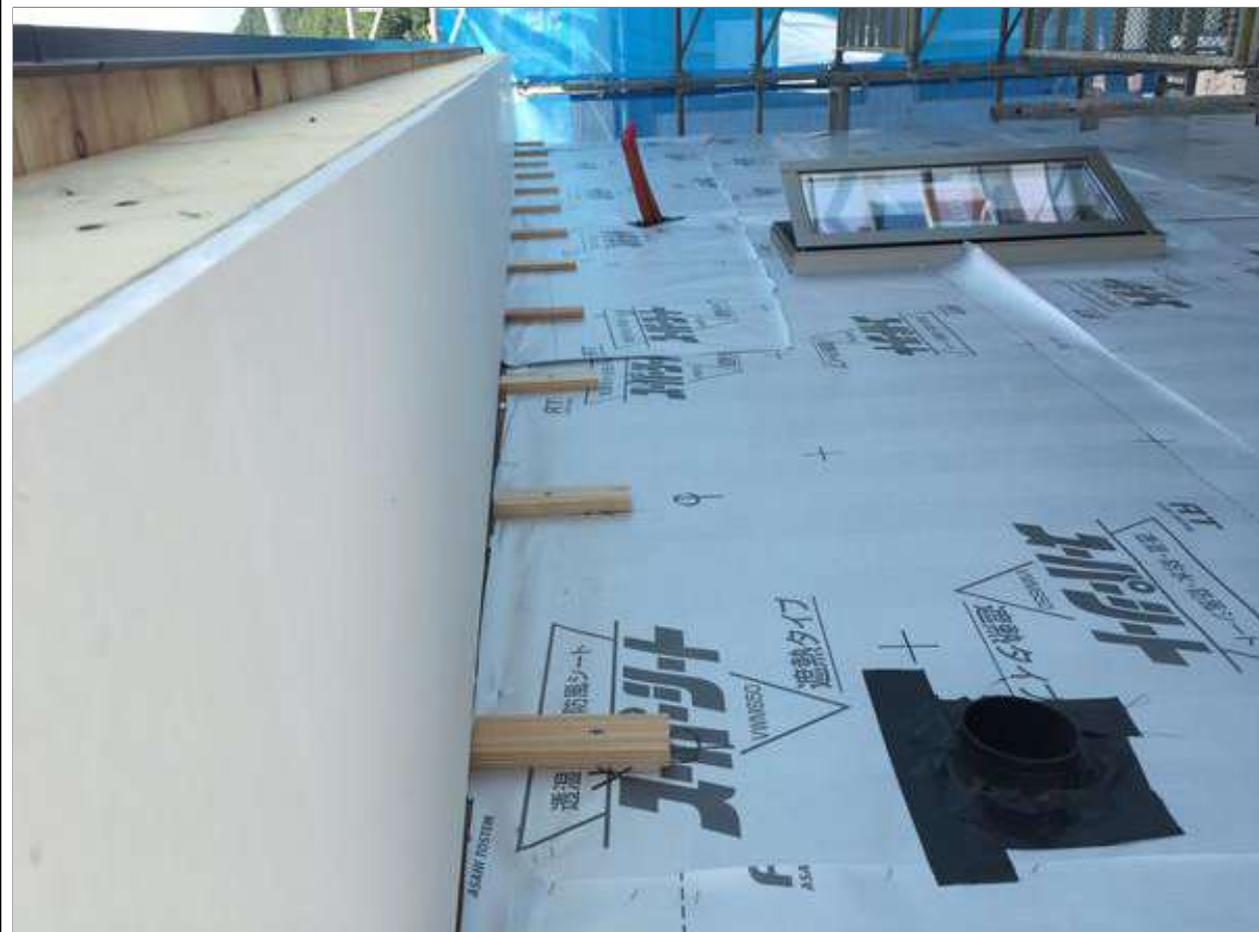
3-5口透湿防水シート（防水紙）の重ね代は、左右150mm、上下90mm以上取る。ステープルのピッチは100mmを目安とする。出入隅部は重ねつくりの施工をし、その際重ね代を150mm以上確保し、かつ重ね部分を乱にする。(1/2)
