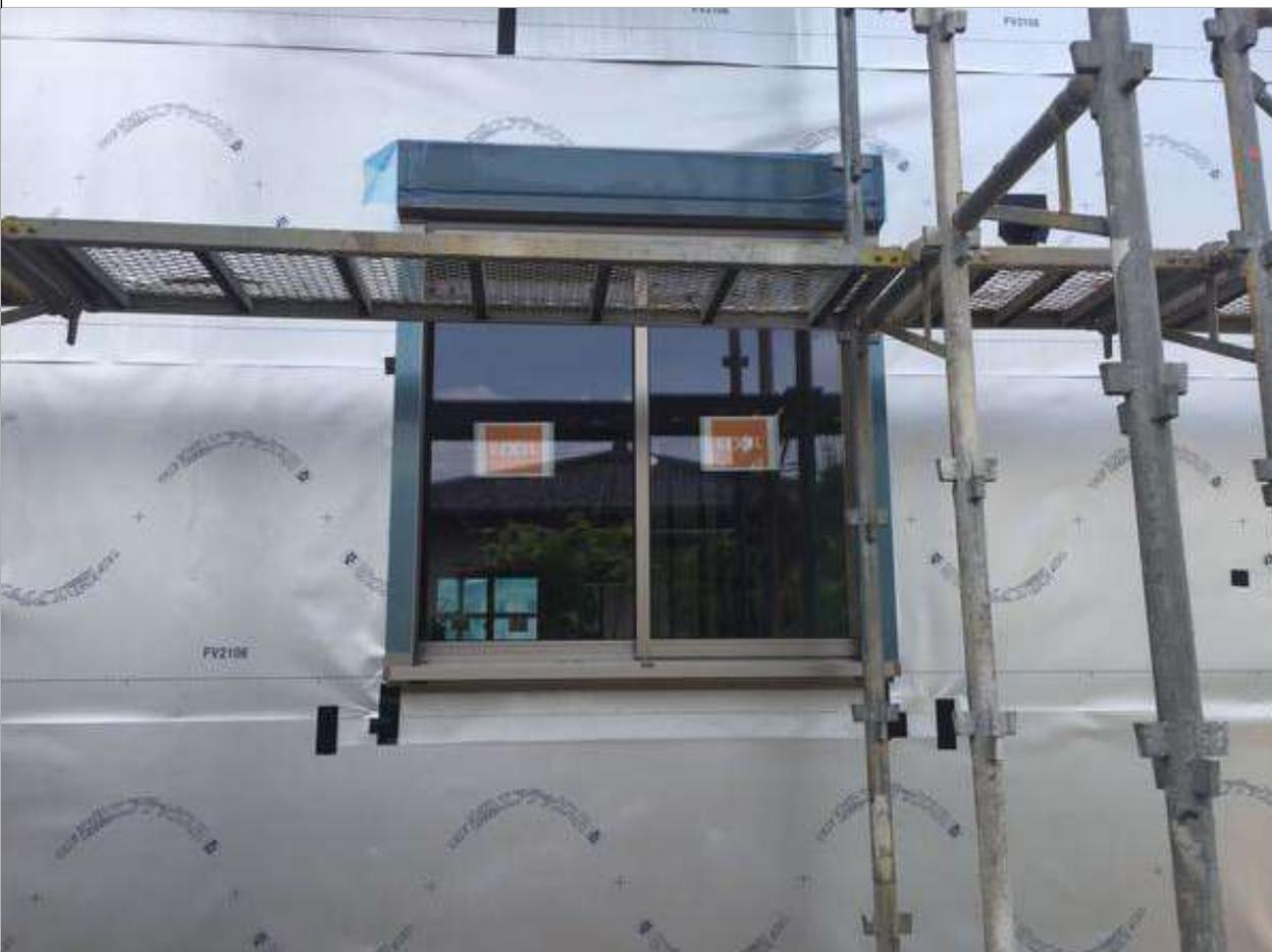
3-3口防水テープの幅は、適切な寸法のものを使用する。
