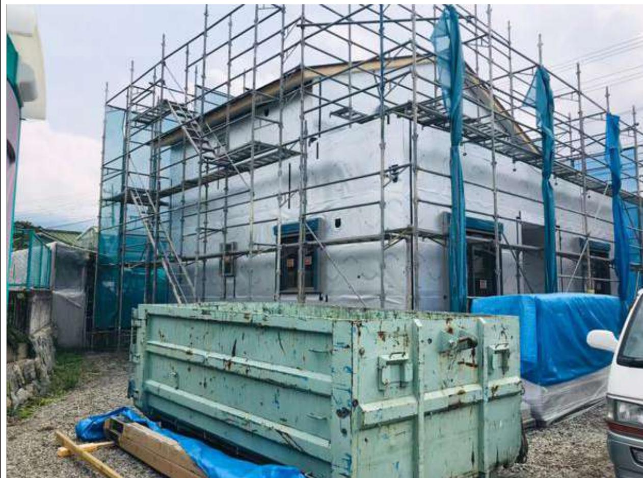
3-5口透湿防水シート（防水紙）の重ね代は、左右150mm、上下90mm以上取る。ステープルのピッチは100mmを目安とする。出入隅部は重ねつくりの施工をし、その際重ね代を150mm以上確保し、かつ重ね部分を乱にする。(2/2)
