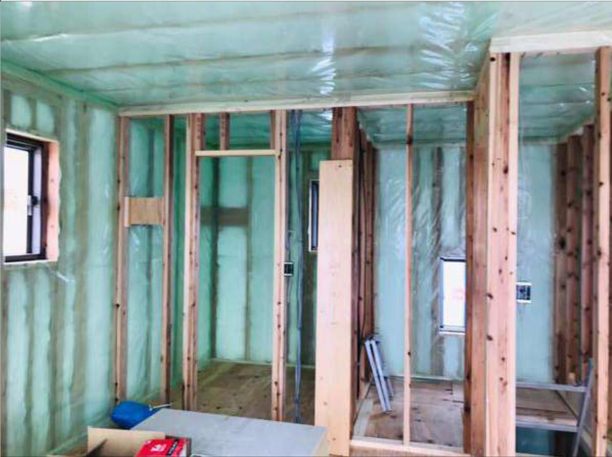
2-1口床・壁・天井（屋根）に図面通りの断熱材を使用する。(2/3)
