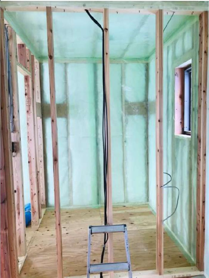
2-3口断熱材は隙間・欠損・施工不良がないように施工する。断熱材は配管部分に隙間ができないように気を付ける。(2/2)
